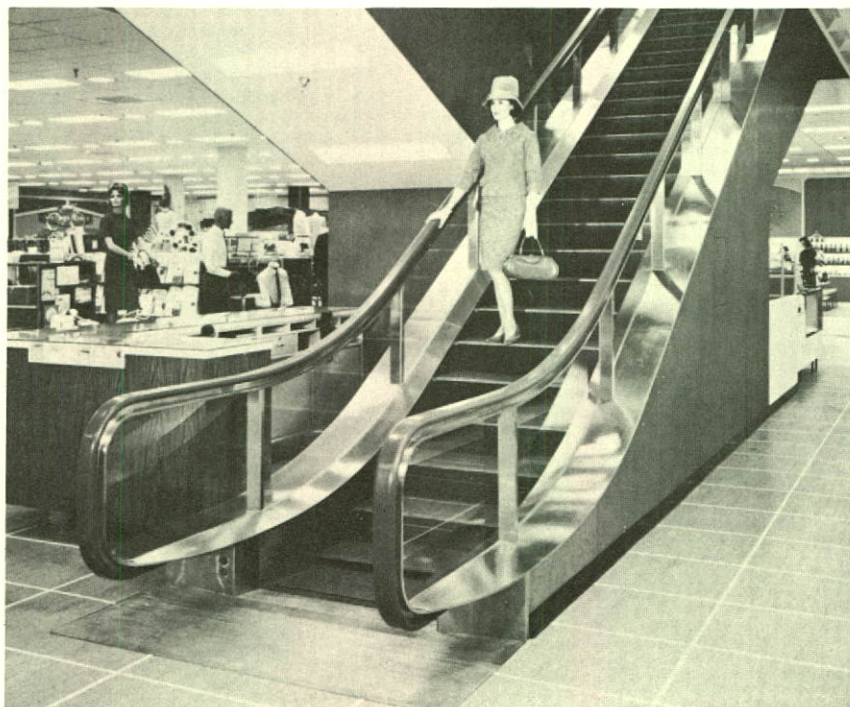
Les magasins à la page utilisent les escaliers électriques Westinghouse et ceux-ci contribuent à rendre votre magasinage plus plaisant et plus facile.
