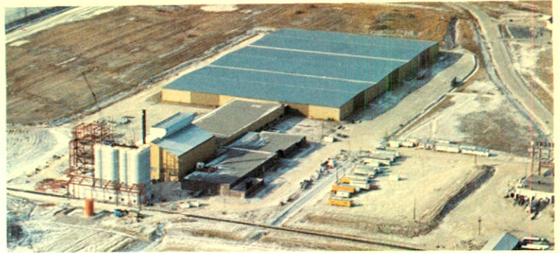
La nouvelle usine de Milton, Ontario en construction
