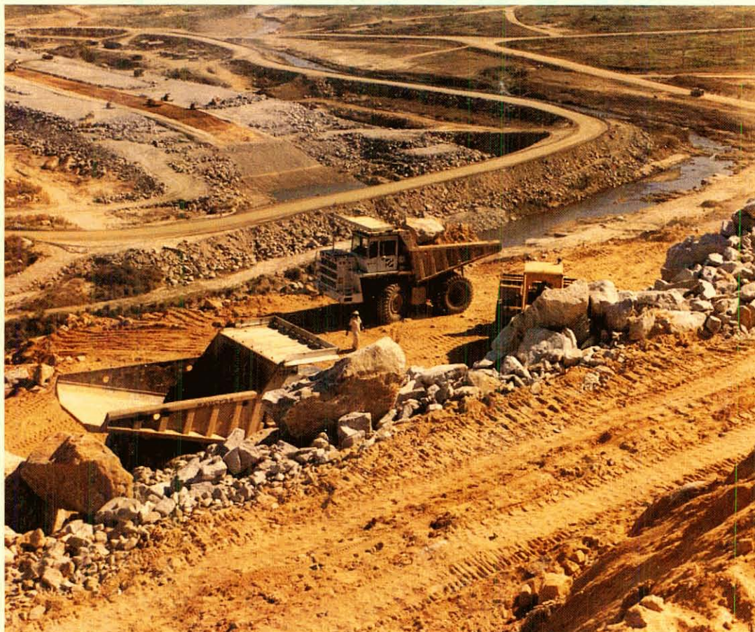
Construction d'un barrage en enrochement de 1000 m de longueur et 40 m de hauteur, au projet d'irrigation de Maduru Oya au Sri Lanka, exécuté en consortium.
