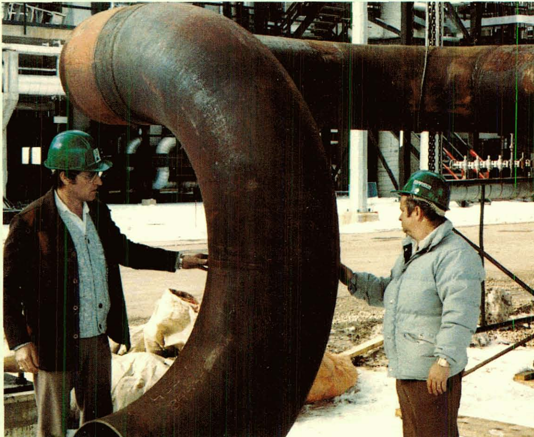
Inspection de tuyau de 18", à vapeur, assemblé à la raffinerie Imperial Oil de Strathcona, Edmonton, Alberta.
