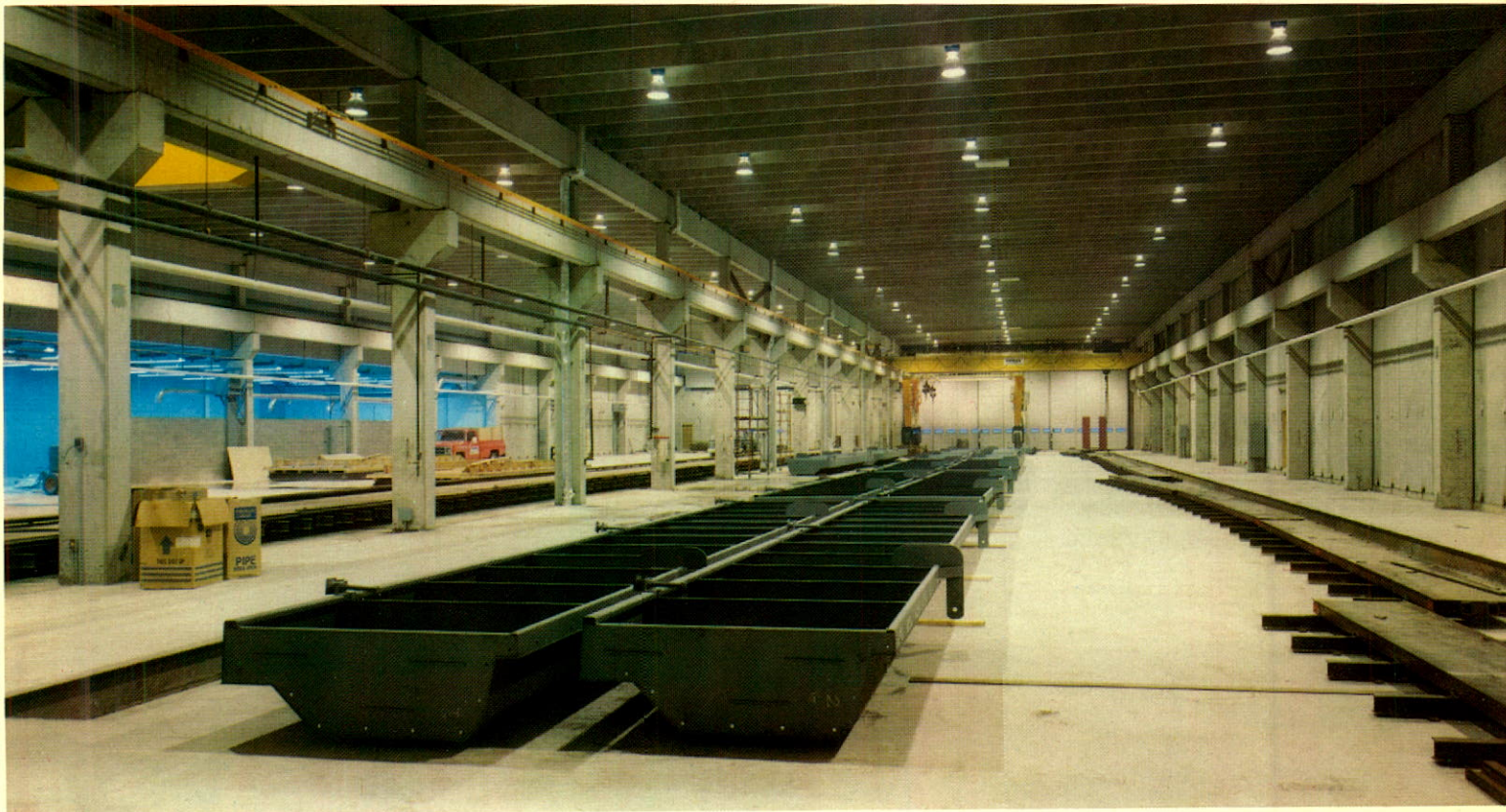
Vibrek Inc.—Nouvelle usine pour la fabrication de béton préfabriqué et précontraint.
