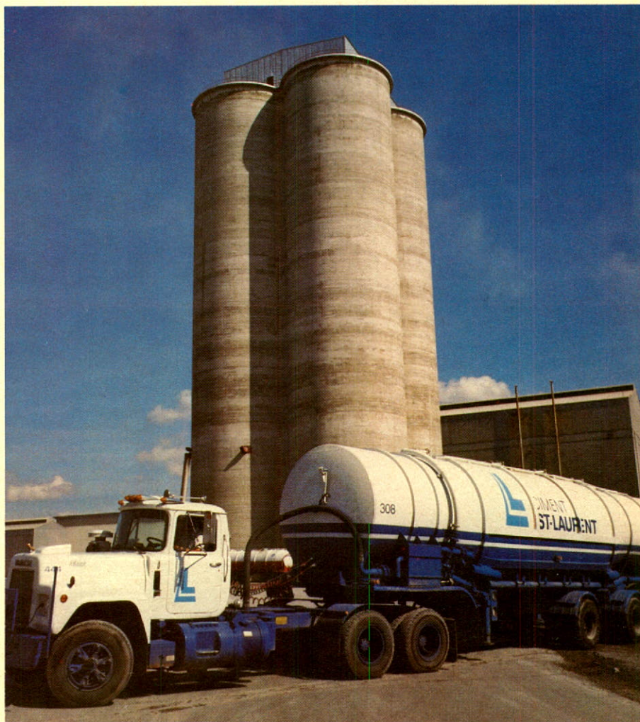
Nouveaux silos à ciment à l'usine de Joliette d'une capacité de 10,000 t. chacun.
