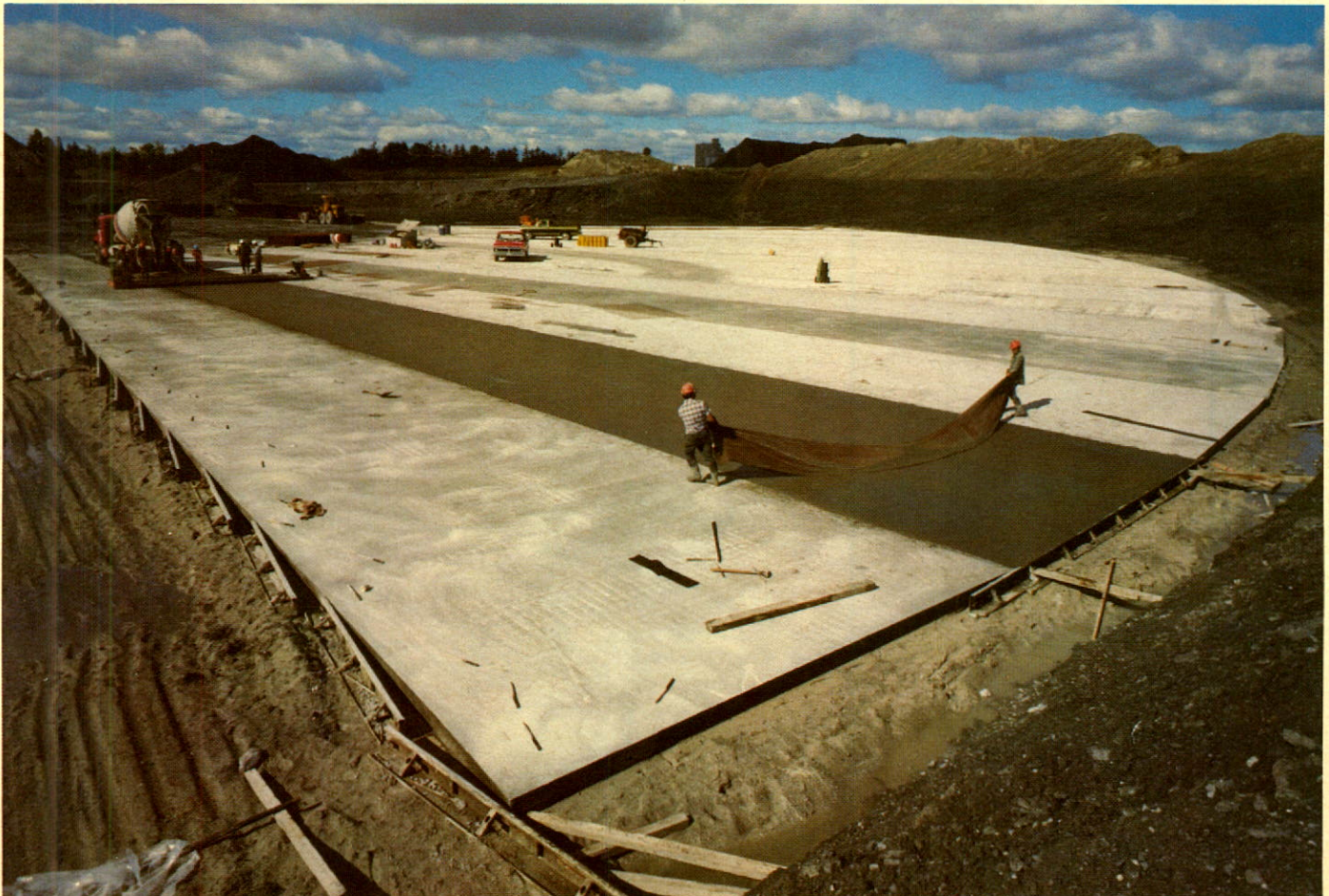
Base en béton pour le stockage du charbon à l'usine de Mississauga.
