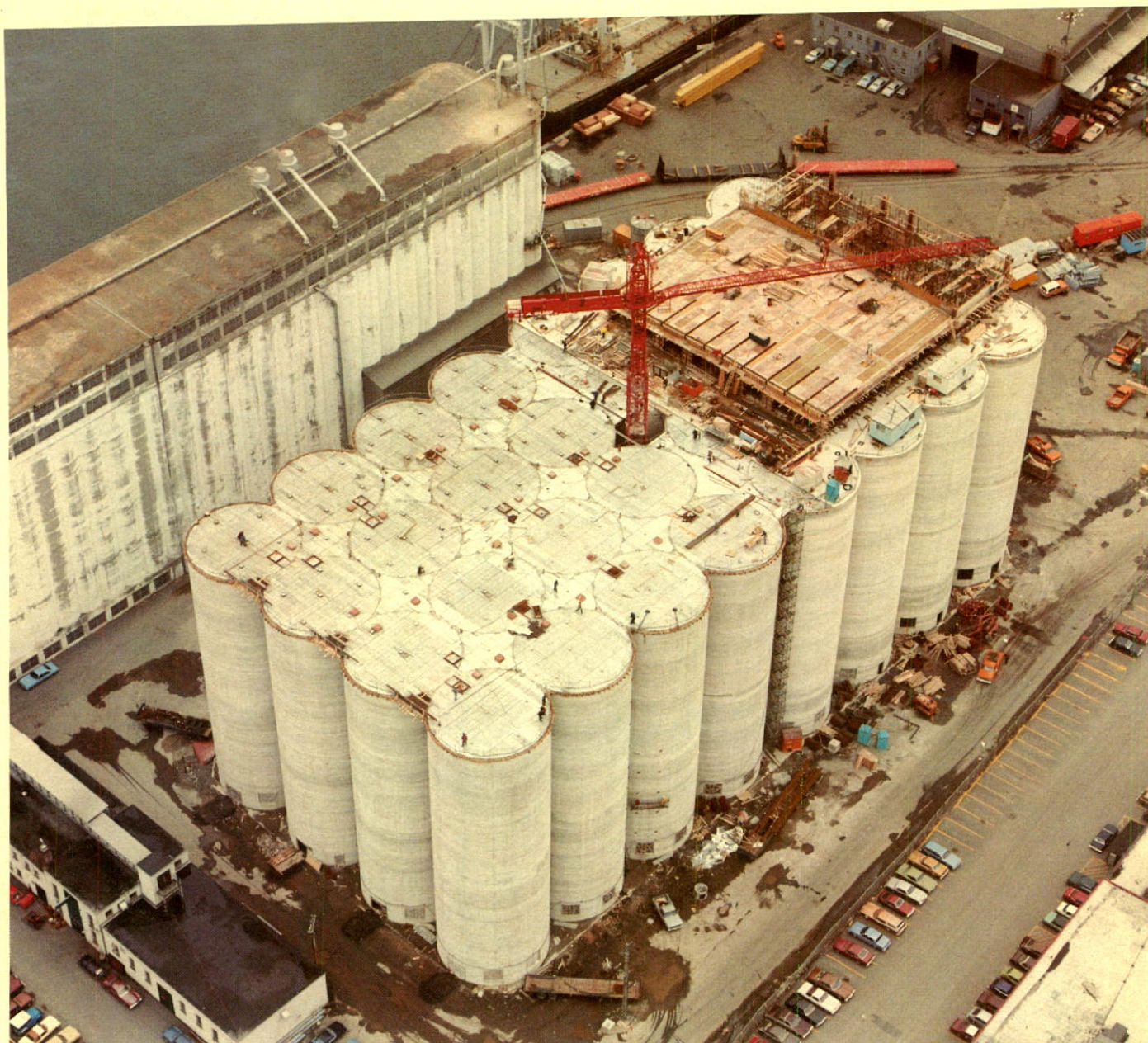
Trente-deux silos à grains, Port de Montréal. Béton fourni par Demix-Béton.
