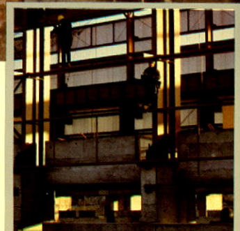
Agrandissement de l'usine de la Société canadienne de métaux Reynolds Limitée située à Baie Comeau. Plus de 65 000 mètres cubes de béton ont été fournis par Béton Manicouagan et utilisés dans la construction des structures en béton armé des deux salles de cuves D1 et D2.
