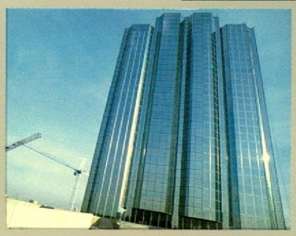
"Le Consilium", immeuble de prestige abritant des bureaux, situé à Scarborough, Ont. Le béton a été fourni par Dufferin Concrete Products.
