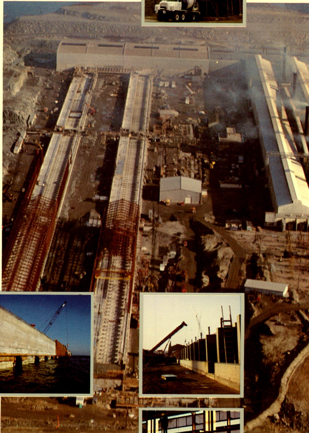
Agrandissement de l'usine de la Société canadienne de métaux Reynolds Limitée située à Baie Comeau. Plus de 65 000 mètres cubes de béton ont été fournis par Béton Manicouagan et utilisés dans la construction des structures en béton armé des deux salles de cuves D1 et D2.
