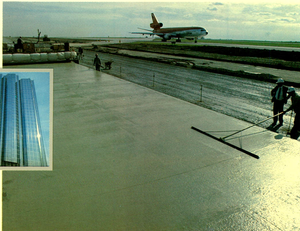
Paveuse de Dufferin Construction faisant la mise en place de dalles de béton de 15" d'épaisseur pour les voies de circulation d'approche de
