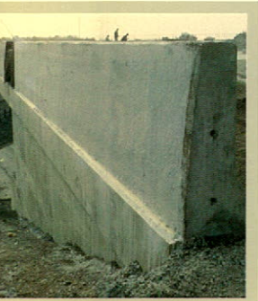
Vue de l'échangeur des Autoroutes 401 et 403 dans la région ouest de Toronto. Le béton a été fourni par Dufferin Concrete Products.
