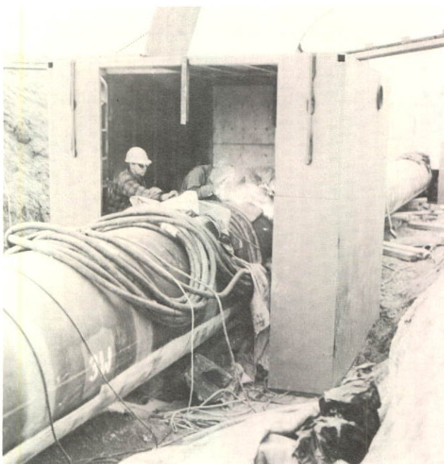
Soudage du tuyau muni d'instruments qui servira à mesurer la vitesse des bris, le mode de décompression du gaz et la déflexion de l'acier, à l'installation pour les essais de résistance des tuyaux, à Rainbow Lake (Alberta). Mise en place par la Foothills, cette installation est la plus moderne des trois qui sont exploitées dans le monde. Achevée en décembre 1979, elle a été construite dans le cadre du projet de gazoduc de la route de l'Alaska.
