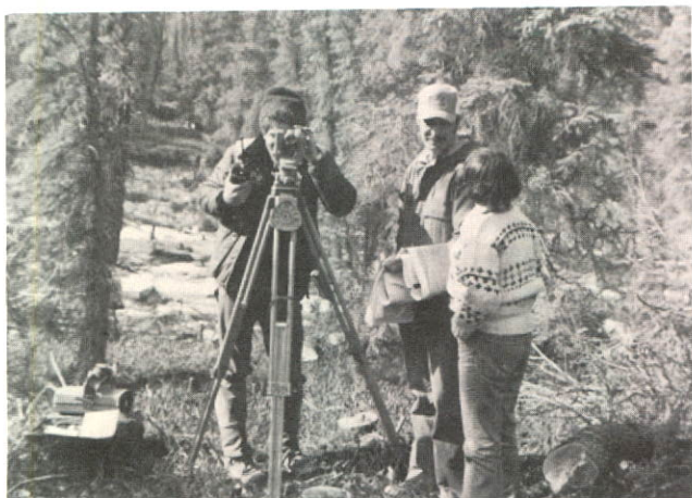
Arpentage et déblayage d'une ligne de deux mètres le long de la limite sud de l'emprise projetée du pipe-line pour établir le tracé final. Maureen Jensen (1 re à droite), coordonnatrice des relations avec les collectivités, discute des progrès réalisés avec l'équipe d'arpentage.
