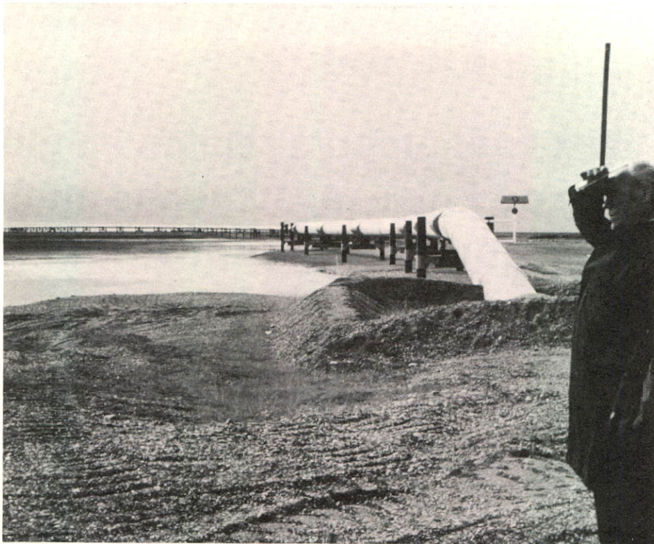
En voyage sur les bords de la baie Prudhoe en septembre 1979, M. Mitchell Sharp, directeur général de l'Administration, regarde le point de départ de l'oléoduc Trans-Alaska qui relie le versant nord de l'Alaska au port de Valdez, à 800 milles vers le sud. Le gazoduc de la route de l'Alaska longera l'oléoduc, sur la plus grande partie du tracé, jusqu'à Fairbanks (Alaska), de là il s'orientera vers le sud-est, le long de la route de l'Alaska, jusqu'au Yukon.
