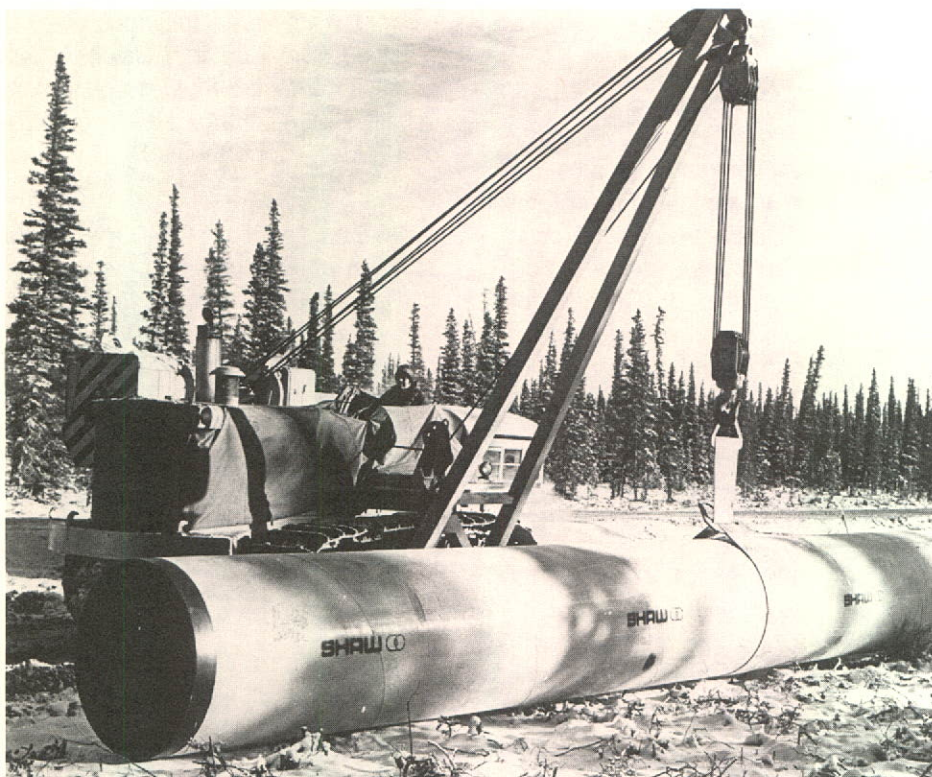
Un tracteur à bras latéral manœuvre des tuyaux à l'installation d'essai de la Foothills, située à Quill Creek, près du lac Kluane (Yukon).
