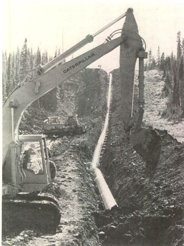
Remplissage de la tranchée dans la zone de la crête Flathead, dans le sud de la Colombie-Britannique.
