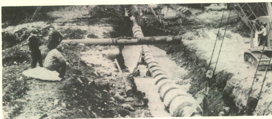
Avant la pose des tuyaux, un canal d'amenée est installé à travers le ruisseau Tee Pee, dans le sud de la Colombie-Britannique.
