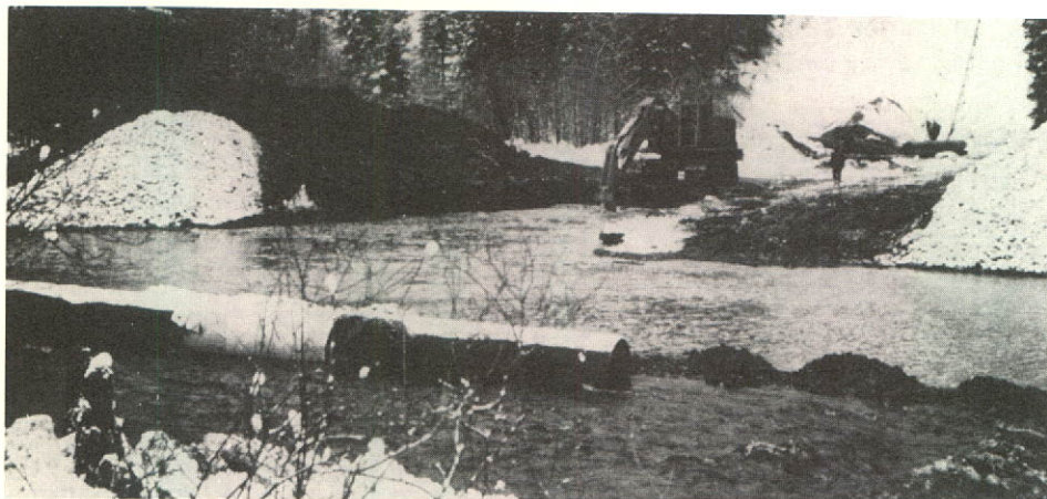
Creusement d'une tranchée dans le lit de la rivière Moyie, au premier des trois points qui enjambent la rivière Moyie, dans le sud-est de la Colombie-Britannique.
