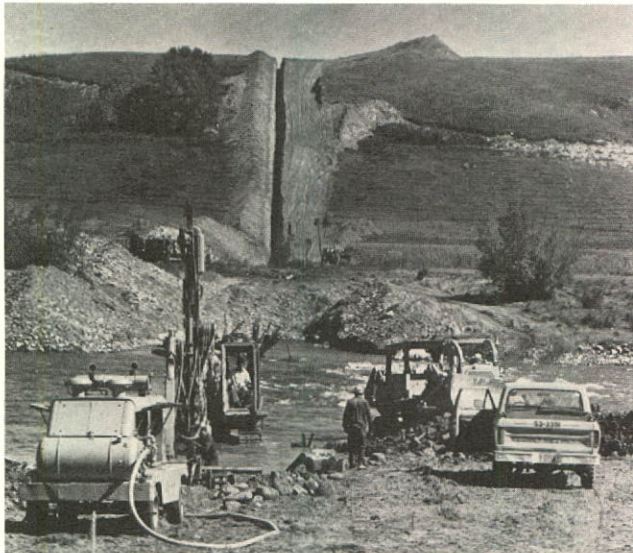
Creusage du fossé à travers la roche de fond de la rivière Bow, à l'ouest de Calgary, en prévision de l'installation de la canalisation.
