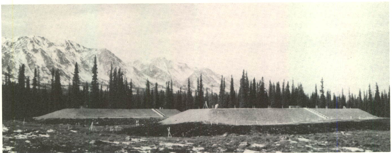
A l'installation d'essai de Quill Creek, que la Foothills (South Yukon) Ltd. a aménagée pour déterminer la faisabilité de la construction et de l'exploitation d'un gazoduc dans des zones de pergélisol discontinu, des tuyaux sont posés dans des remblais dont la hauteur à partir du niveau du sol est de 3,3 mètres (10 pi). Les remblais consistent en des tampons de gravier sur lesquels des couches isolantes et des tuyaux sont posés, puis couverts de gravier. Afin de vérifier l'affaissement dû au dégel, on ensevelit également des tuyaux de la manière habituelle.
