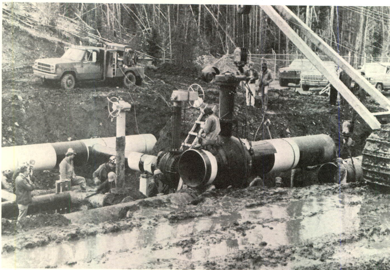
Raccordement de l'embranchement ouest au réseau de l'Alberta Natural Gas Company Ltd. dans la région du Pas du Nid-du-Corbeau, dans le sud-est de la C.-B., en mai 1981.
