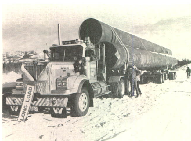
Des ensembles articulés autovireurs, chargés de tuyaux de 23m (76 pi) qui seront mis à l'épreuve le long de la route de l'Alaska.
