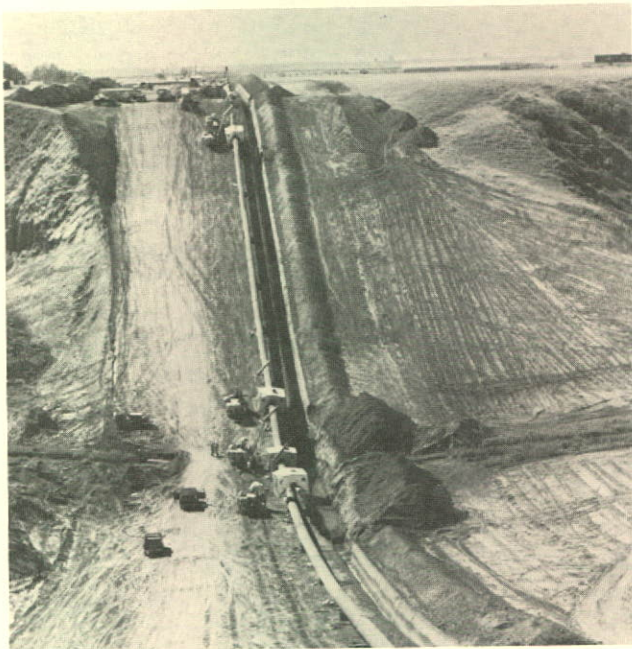
Des soudeuses automatiques sont descendues dans la Irishman's Coulee (est de l'Alberta) à 45m (140 pi) de profondeur.
