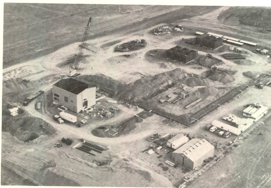
Vue aérienne, en novembre 1981, des installations de la station de compression en construction à Jenner en Alberta.
