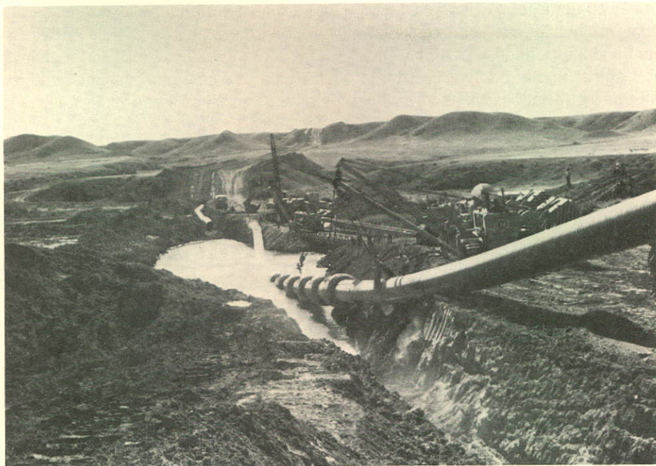
Des grues latérales descendent le pipe-line dans le lit de la Frenchman, dans le sud-ouest de la Saskatchewan.
