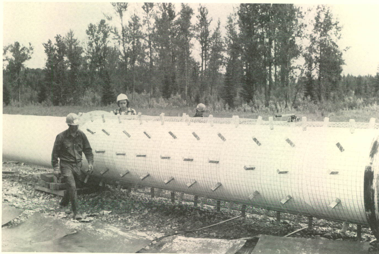
Des équipes de construction enrobent un tuyau d'un treillis métallique avant de le recouvrir de ciment.
