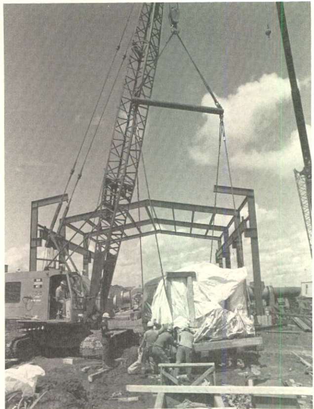
Mise en place du second compresseur actionné à l'électricité de la station de compression de Jenner, en Alberta.
