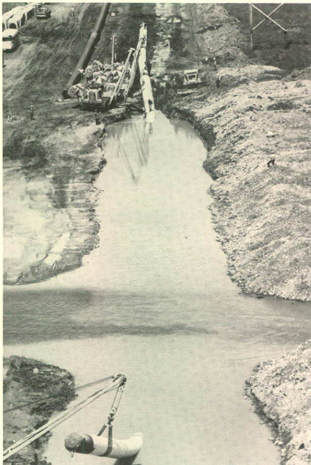
Des grues latérales descendent le pipe-line dans le lit d'une rivière pendant la construction de l'embranchement est.
