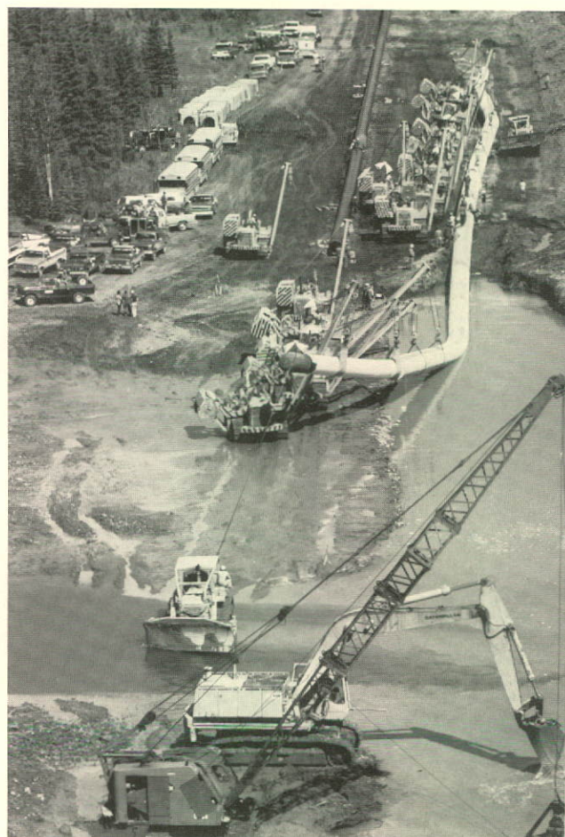
Des équipes de construction se préparent à descendre le pipe-line dans le lit d'une rivière pendant la construction de l'embranchement est.
