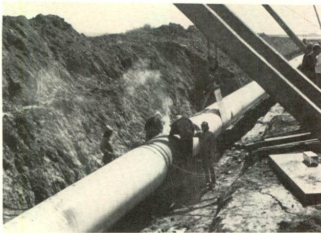
Avec la dernière soudure de jonction, faite le 17 août 1982 au sud de Beiseker (Alberta), prend fin la construction de l'embranchement est du pipe-line au Canada.
