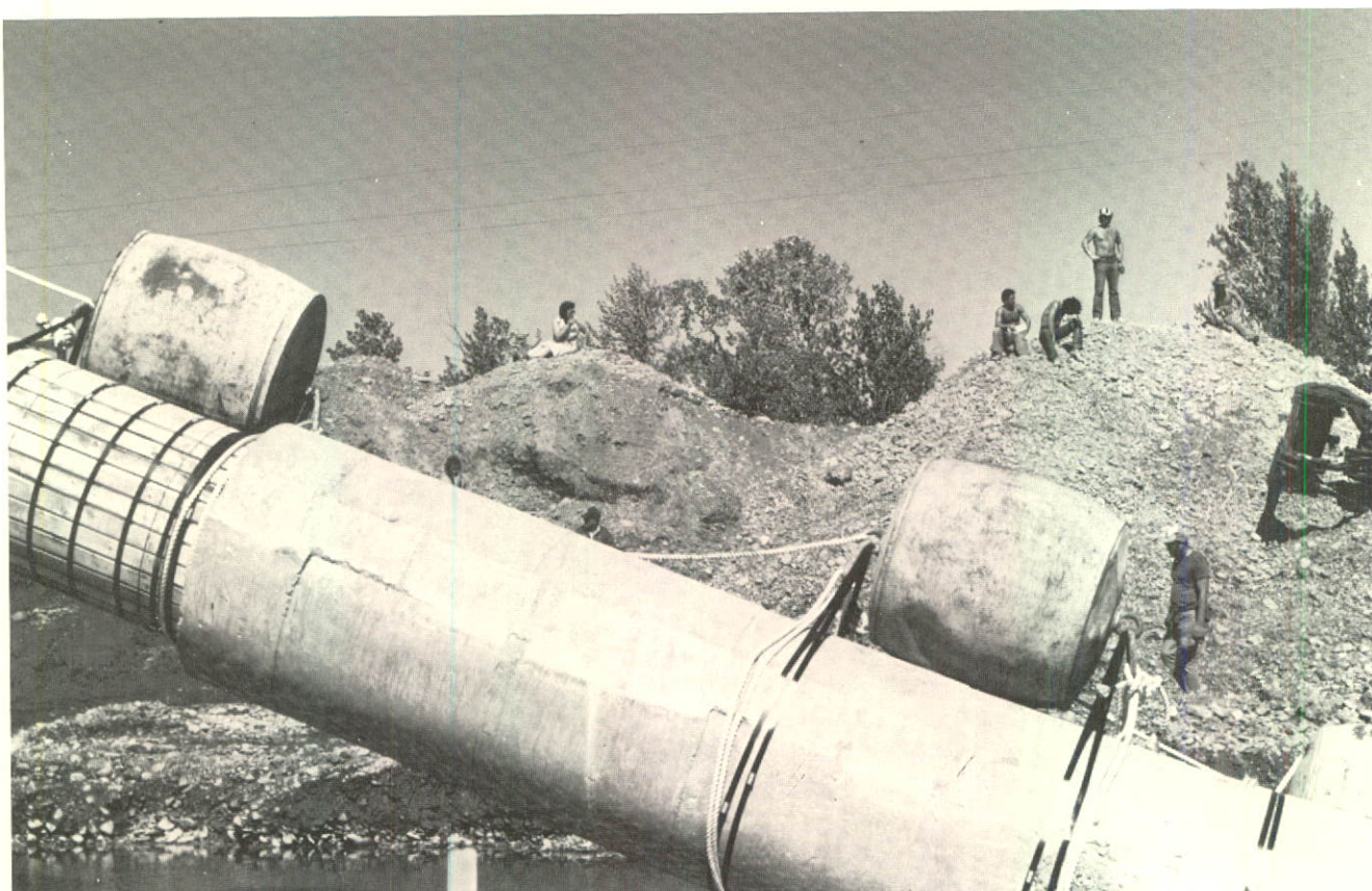
Des flotteurs sont fixés à la canalisation pour la maintenir à flot pendant le passage d'un important cours d'eau à travers lequel elle sera tirée.
