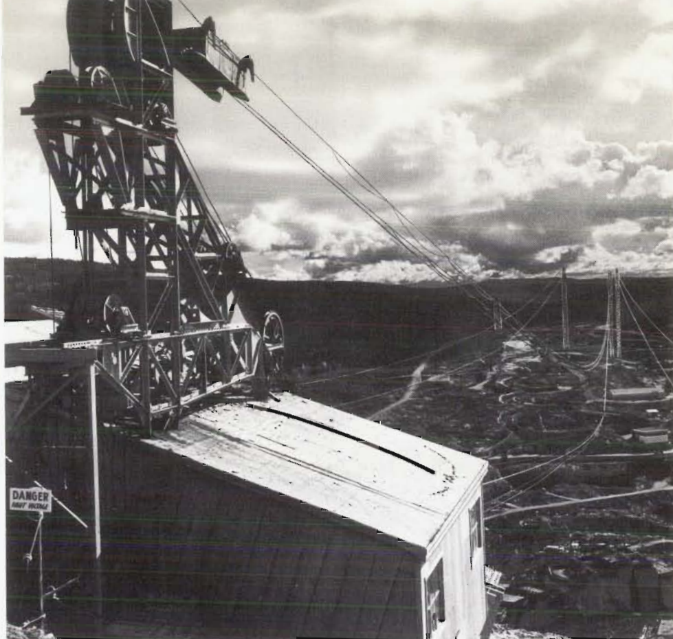
Manic 5 — Téléphérique de plus de 4,000 pieds pour la mise en place du béton.
