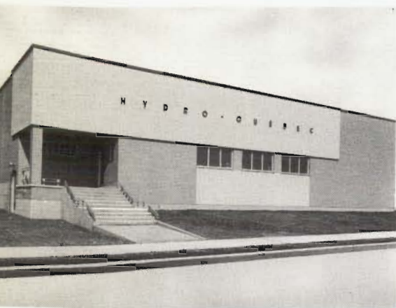
Vue extérieure de la sous-station Moreau.
