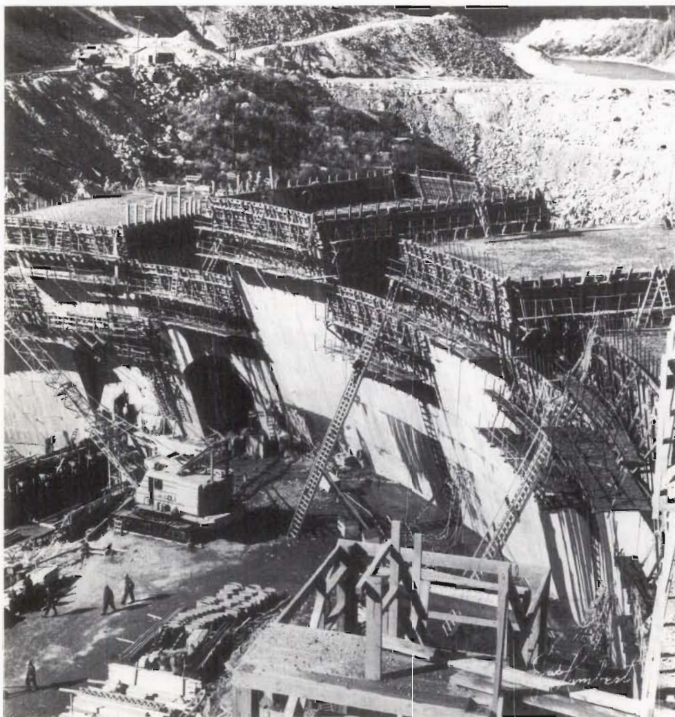
La voûte centrale du barrage de Manic 5 monte rapidement.
