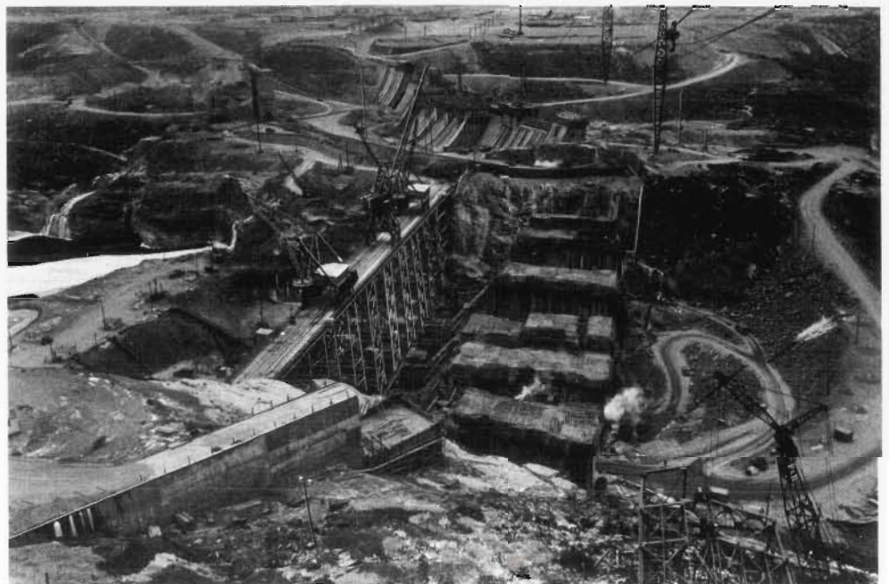
Vue d'ensemble du chantier de Manic 2.
