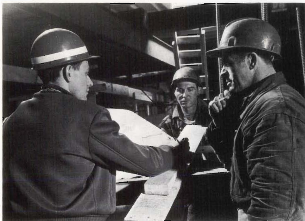
Le personnel technique vérifie les travaux d'après les plans.
