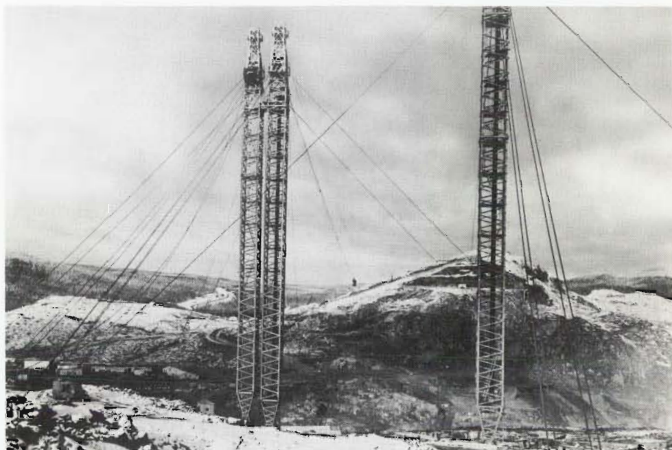
Les très hautes tours du blondin qui sert à la mise en place du béton au barrage Manic 5.
