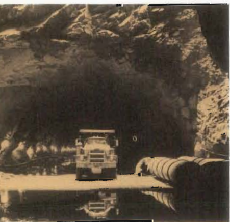
Les galeries de dérivation sont creusées en pleine montagne.
