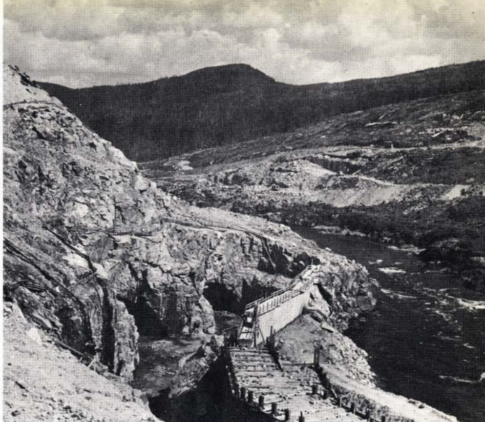
Vue à vol d'oiseau du chantier de Manicouagan 5.
