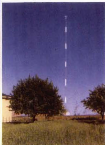
◀ L'un des pylônes du réseau micro-ondes . . . A tower of the microwave system . . .
