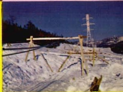
La construction de la ligne se poursuit en toute saison . . . Transmission line construction defies the seasons . . .
