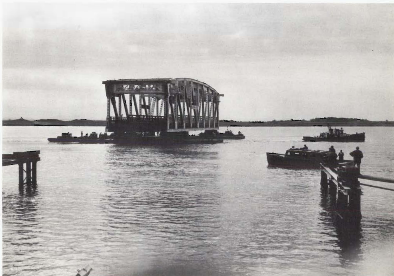
Entreprise délicate réussie par l'équipe de construction de Beauharnois
