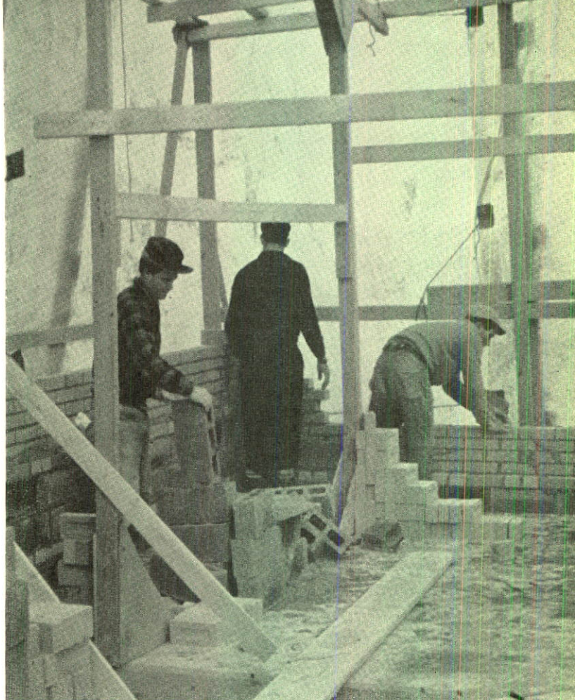
Construction d'habitations au cours des mois d'hiver derrière un abri de polyéthylène.
