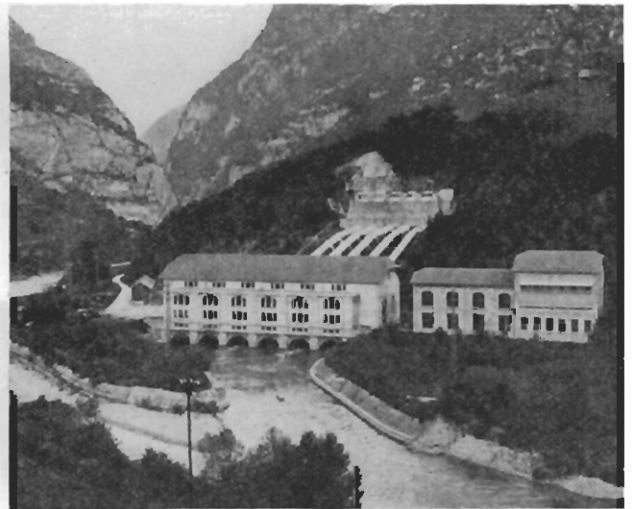
General view of plant at Porte du Fier. Hydro-Electrique de Lyon, (Energie Industrielle).
