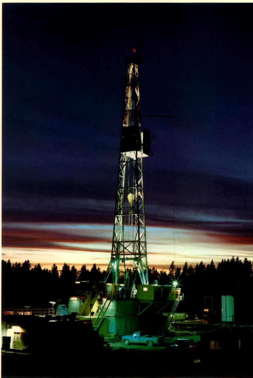
La plus longue colonne de tubages soudé par résistance électrique au Canada, faite de tubes fabriqués par IPSCO à Calgary, a été enfoncée à ce puits de pétrole albertain.
