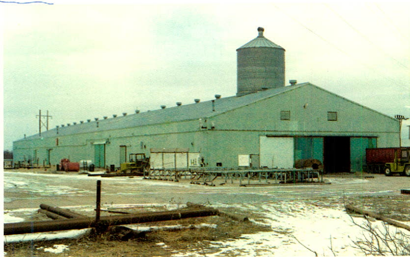
L'usine de tubes de Geneva (Nebraska), nouvelle acquisition d'IPSCO Steel Inc.
