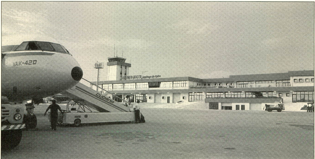
▲ La CCC a adjugé à Regor International Inc. , de Montréal (Québec), des travaux de parachèvement de l'aménagement intérieur et de l'équipement de l'aéroport Antonio Maceo, à Santiago de Cuba.
