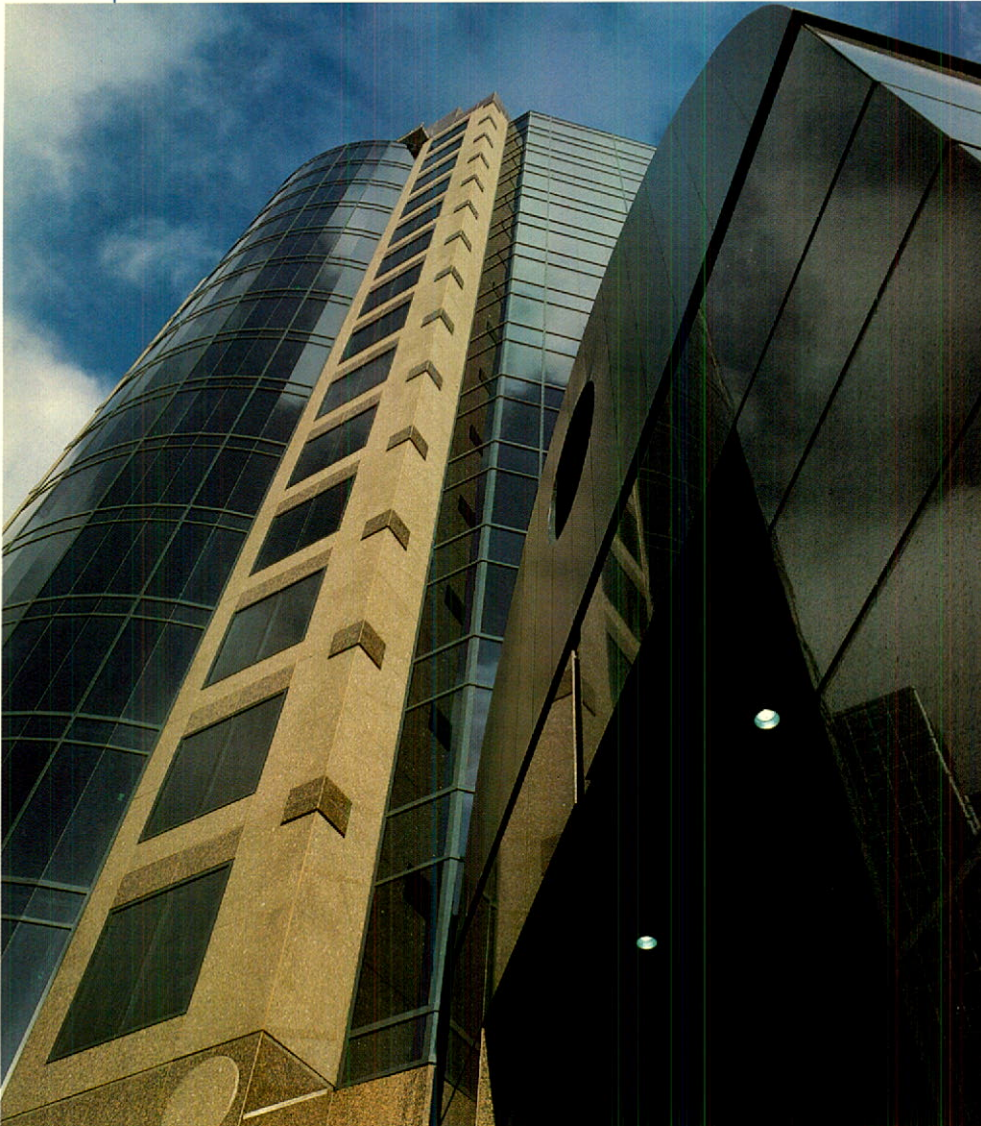
La phase I de Crown Life Place, un complexe de bureaux de 600 000 pieds carrés au centre-ville de Toronto, a été officiellement inaugurée en septembre 1989. Les travaux de la phase II vont déjà bon train.
