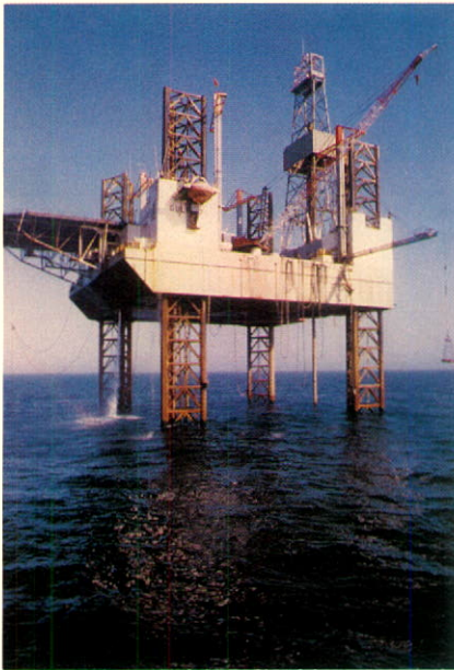
Plate-forme de forage au large utilisée sur la côte Est pour le forage de Venture D-23.
