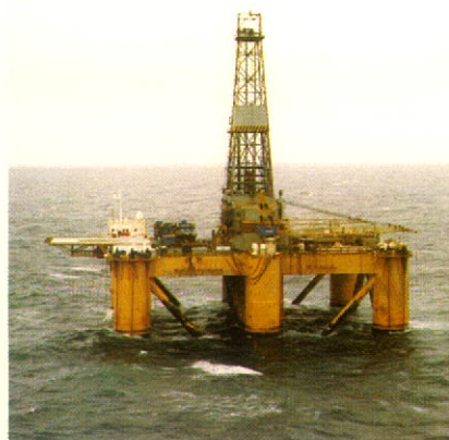
La tour de forage Zapata Uglund est utilisée pour forer le puits Ben Nevis.
