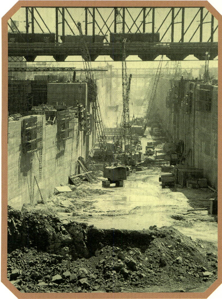
Construction de l'écluse Saint-Lambert, août 1957
