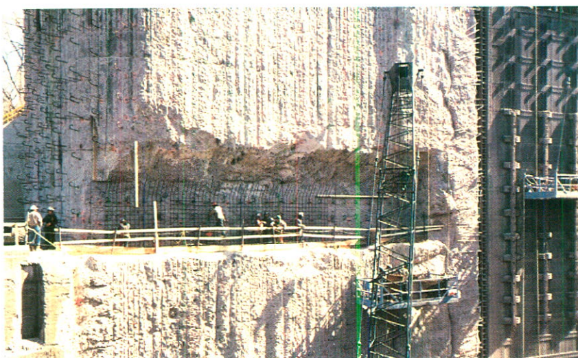
Réfection du canal de Welland : Les ouvriers installent l'armature d'acier qui consolidera le revêtement d'un mur d'écluse.
