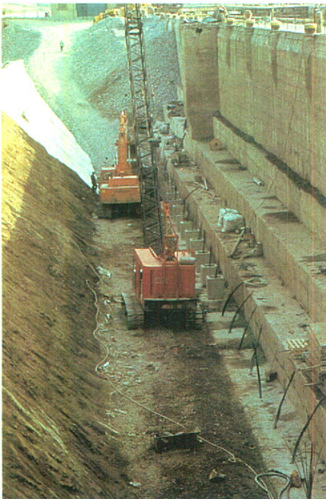
La réfection du canal de Welland exige que la surface arrière des murs d'écluse soit exposée pour l'installation des tiges de renforcement et du système de drainage.
