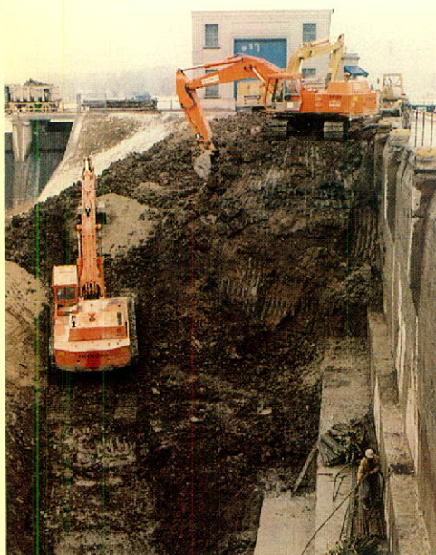
Le programme de réfection du canal de Welland : Les ouvriers exposent l'arrière du mur est de l'écluse 3, lequel a été renforcé pendant l'hiver.
