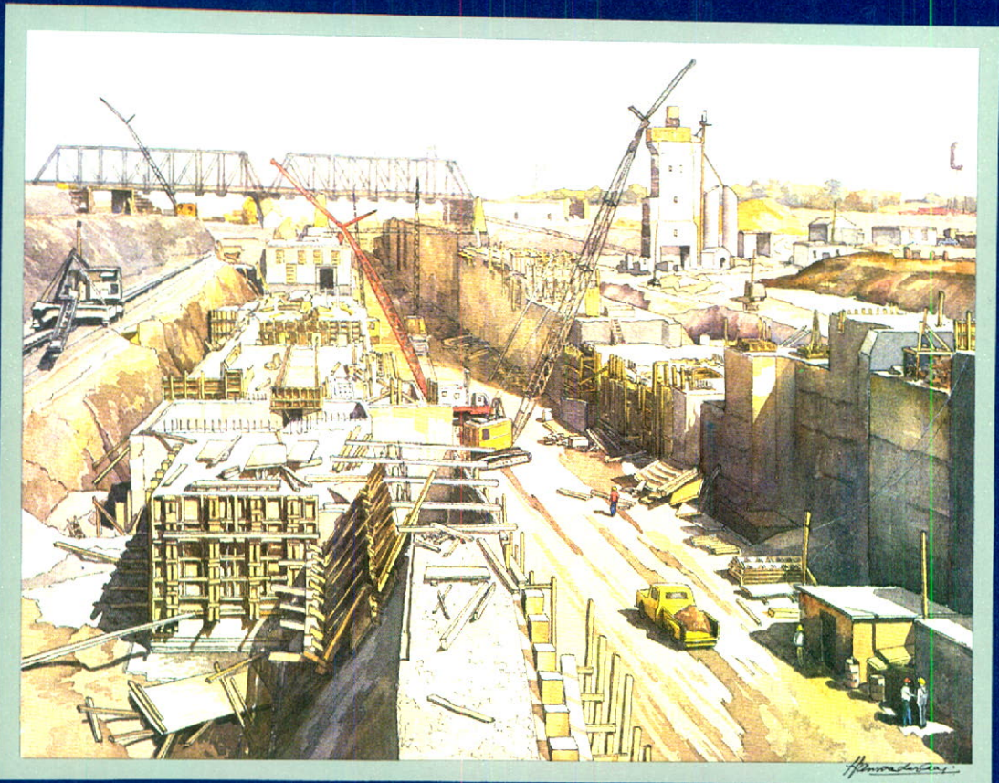
La construction de l'écluse de Saint-Lambert
