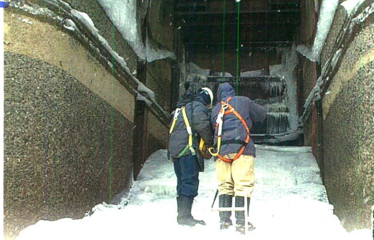
Inspection de l'écluse de Côte-Ste-Catherine
