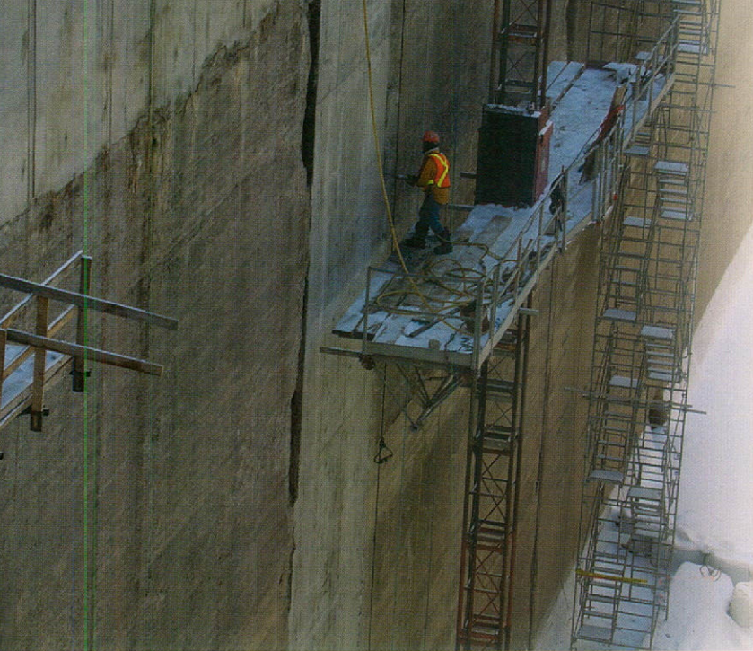
Un entrepreneur regarnit un mur d'écluse durant les travaux hivernaux de 2005.
