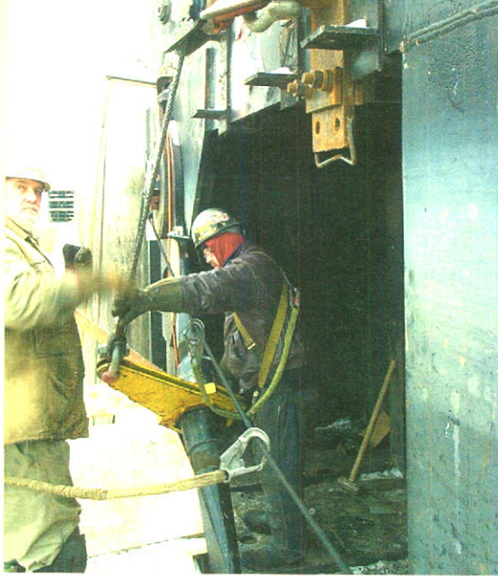
Remise en état des portes aux écluses de Beauharnois
