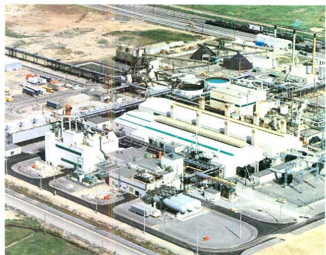
PROJET C.I.L. – Deux sociétés du groupe Monenco, la Société d'Ingénierie Montréal, Limitée et Hatch Associates Ltd. se sont groupées pour fournir les services d'ingénierie et de gestion de la construction de l'usine de chloralcali de C.I.L. à Bécancour, Québec, d'une valeur de $100 millions. Ce projet a été complété avec trois mois d'avance sur le programme et à un coût inférieur au budget. Malgré un programme de construction serré, le temps perdu attribuable à des blessures a été inférieur à la moyenne de l'industrie — le mérite revient aux ingénieurs en sécurité de Hatch.
