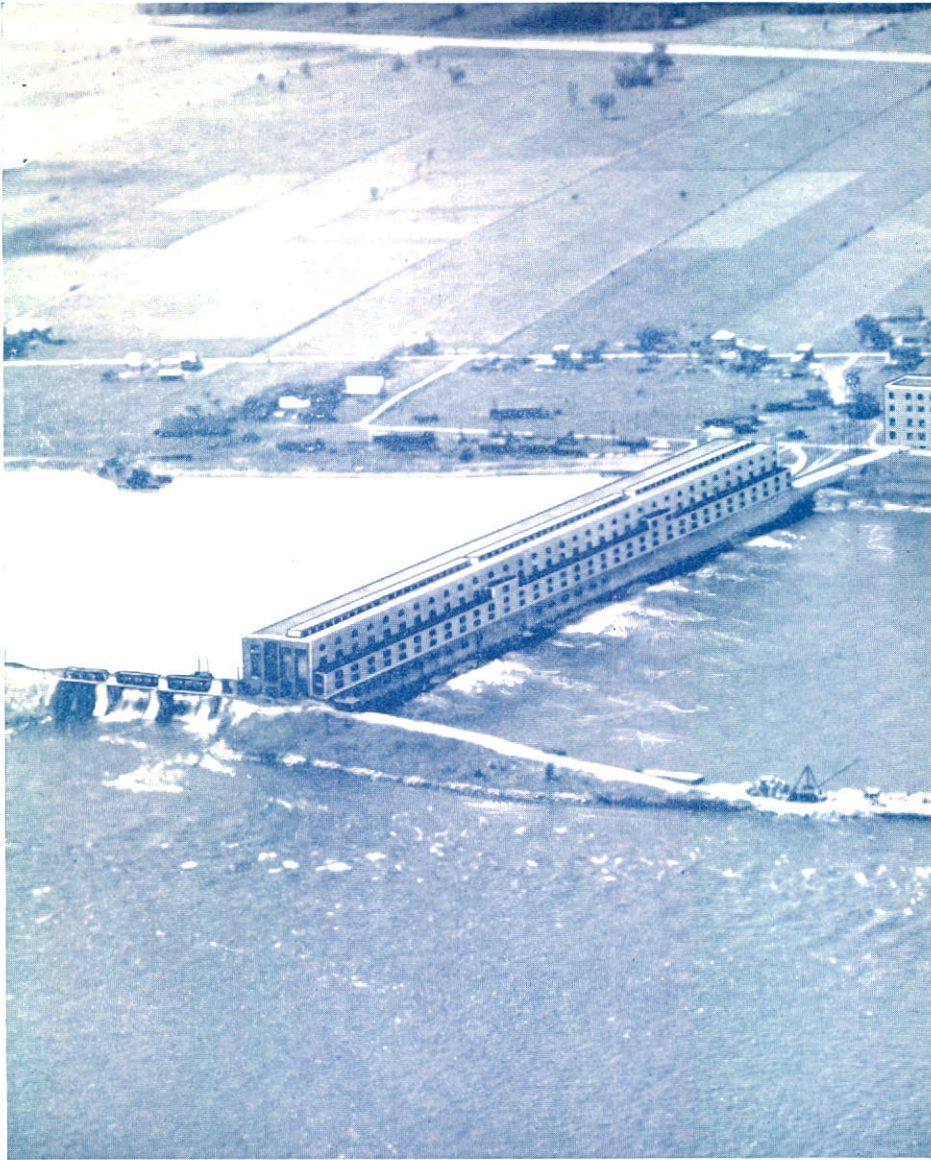
Cedars Rapids Power House of 206,400 H.P. installed capacity, Transformer Usine des Rapides des Cèdres (capacité installée, 206,400 c.v.), bâtisse des t
