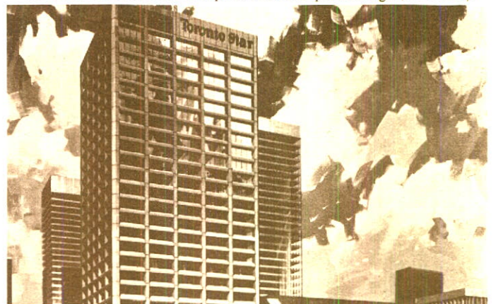
Le nouvel immeuble du Toronto Star Limited, situé au bord du lac Ontario.
