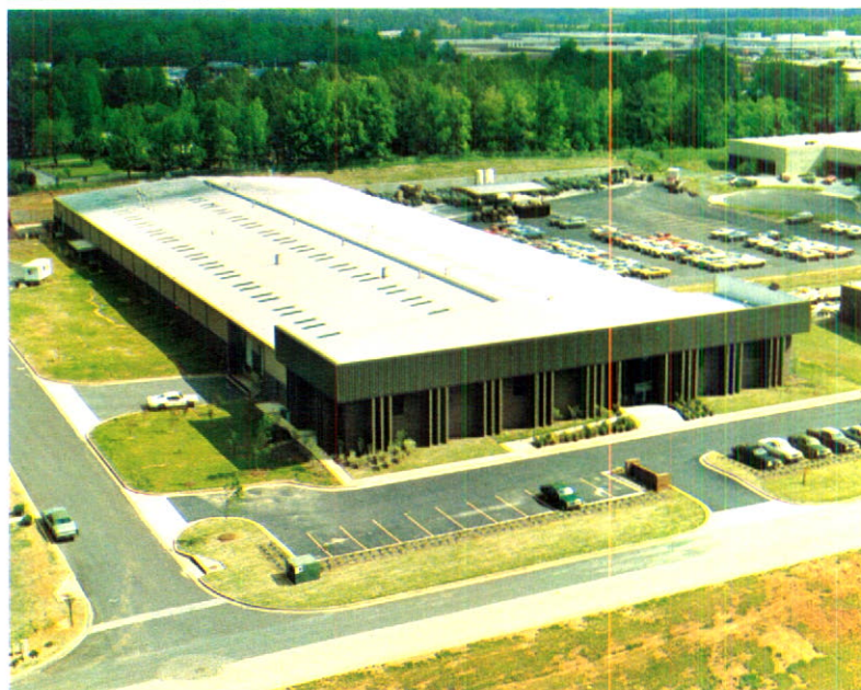
Une usine à façade attrayante fabriquée par Atlantic Building Systems. ▲
