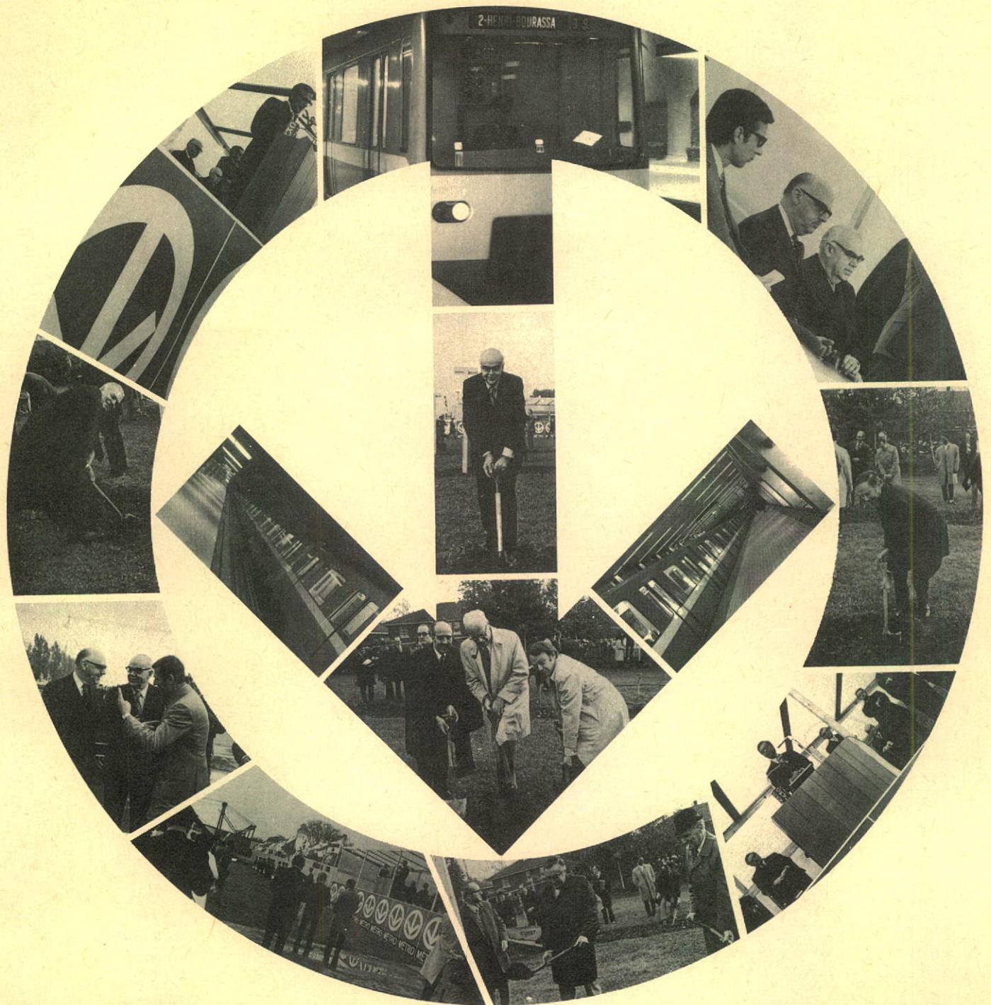
Les plus hautes autorités gouvernementales, municipales et du transport urbain ont pris part à l'inauguration officielle des travaux de prolongement du métro, le 14 octobre 1971.
