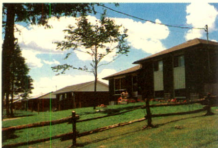
Dans les collectivités de moins de 2 500 habitants, il est possible de construire, acquérir ou remettre en état des logements, en vertu du Programme de logements pour les ruraux et les autochtones.
