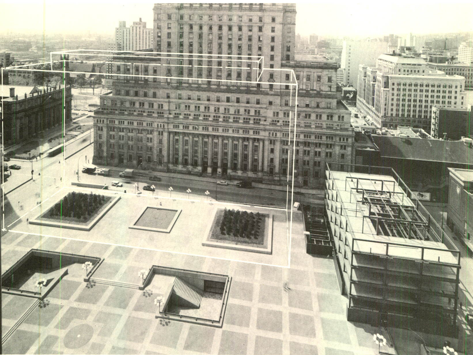
La Plaza de Place Ville-Marie montrant la Maison Greenshields en construction et le site de l'édifice projeté.
