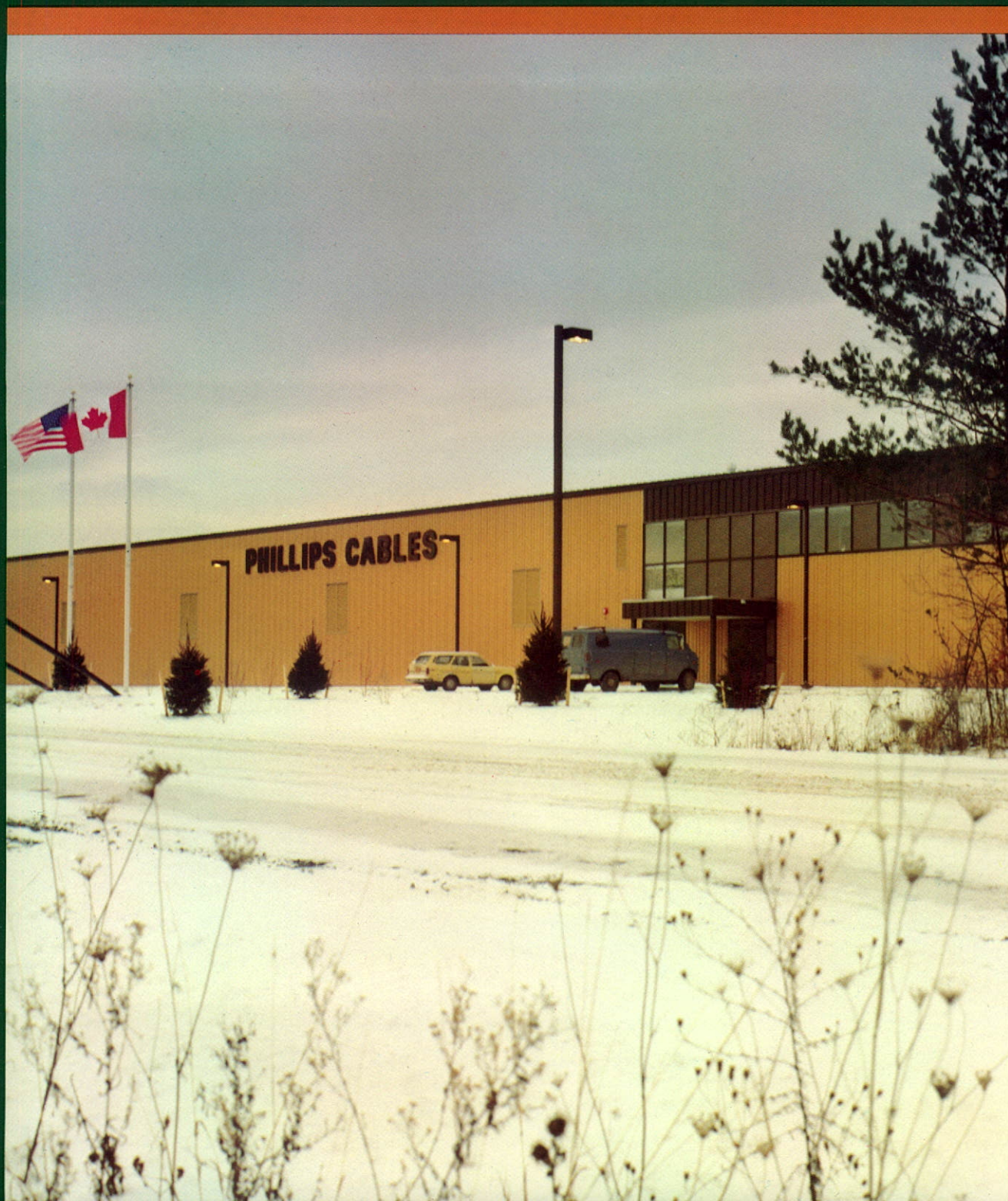
La nouvelle usine de Phillips Cables Incorporated à Watertown, N.-Y. sera officiellement inaugurée en mai 1983.
