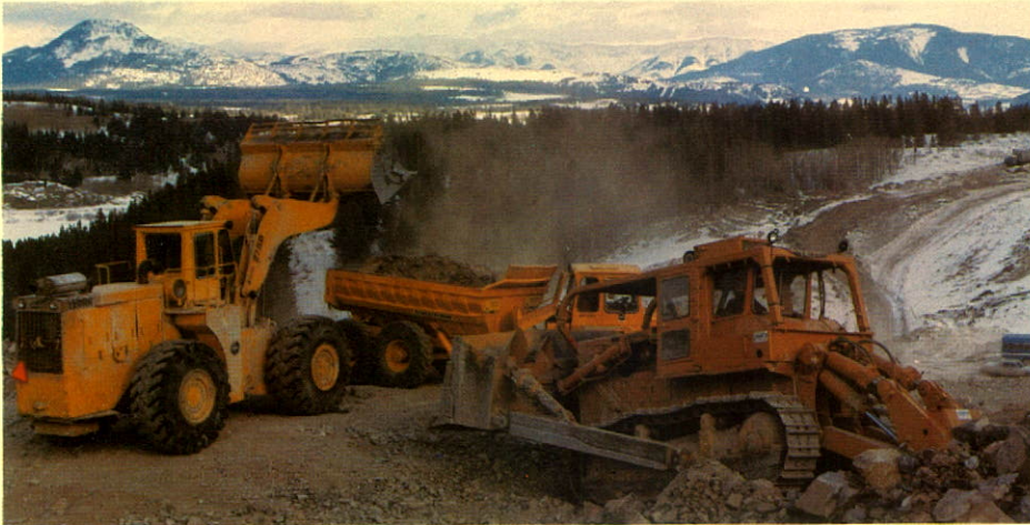
Ce chemin de montagne a nécessité un dynamitage constant et un chargement rapide. Un Clark Michigan 275 B fut utilisé pour le chargement tandis qu'un Komatsu D155A a servi à briser les gros blocs de pierre.
