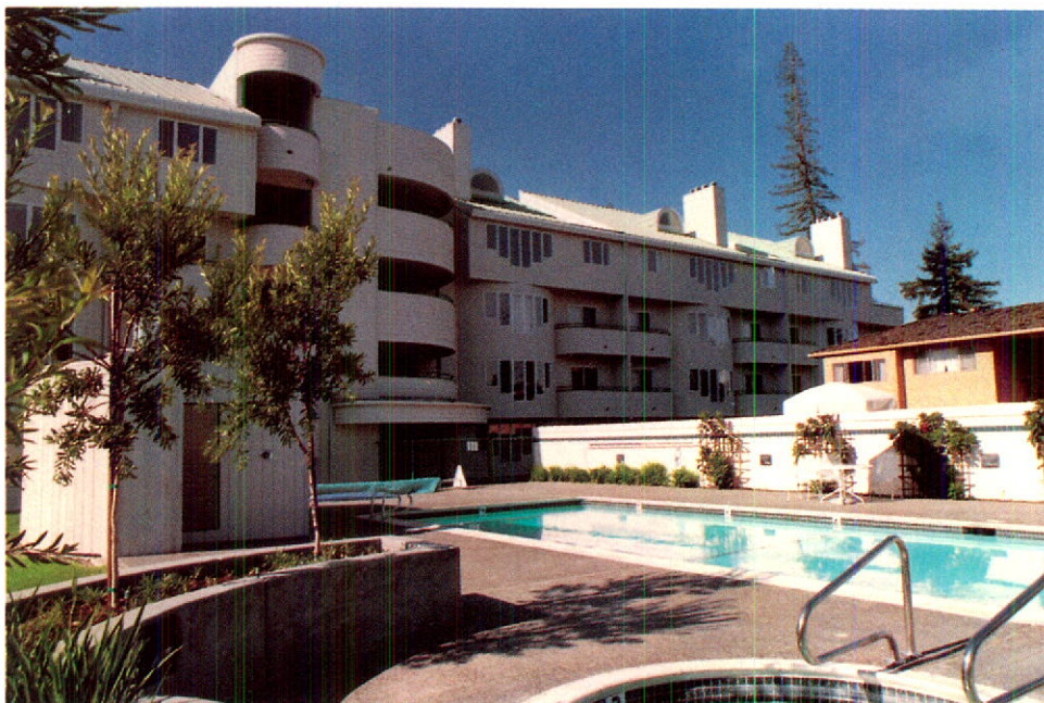
Les appartements Mayfield constituent un complexe d'habitations en copropriété de qualité situé à Palo Alto, en Californie. Les deux immeubles, reliés par des passerelles couvertes sur chaque étage, renferment 66 appartements, dont chacun comprend un hall en marbre et en chêne et une cheminée naturelle en plus de donner accès à un espace de stationnement au sous-sol. La Great-West a fourni le financement hypothécaire du projet, dont la construction a pris fin en mai 1988.
